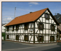
Umbau u. Sanierungen
