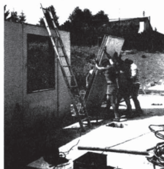
Nach dem Gießen der Fundamente werden die Wände aus Fertigteilen errichtet
